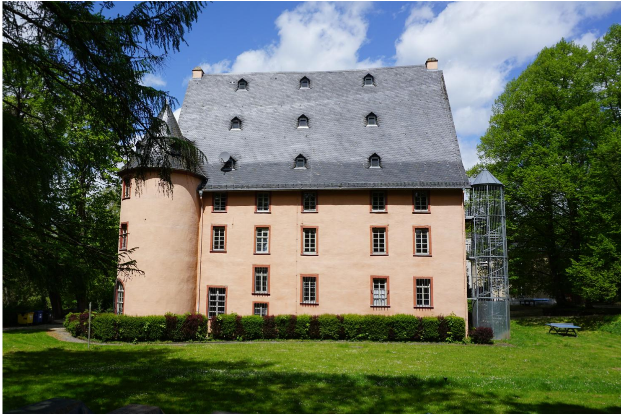
Die Rückansicht der Burg: Das ganze Anwesen soll zukünftig mit einer Wärmepumpe beheizt werden.
